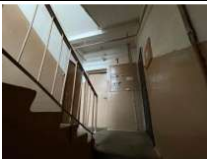
1.stāva kāpņu telpa
